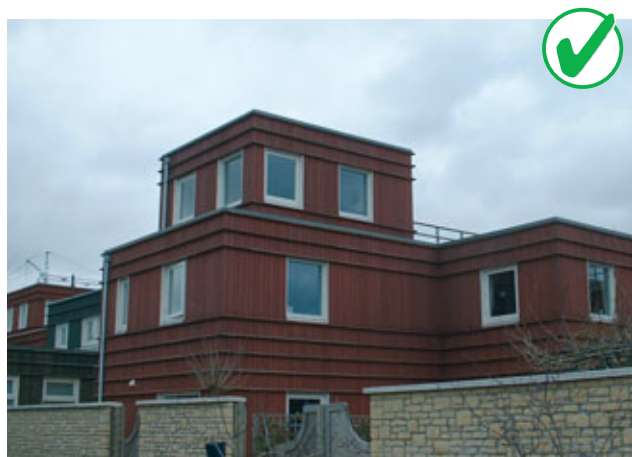
Drie lagen kleurbeits op fijnbezaagd oppervlak.
